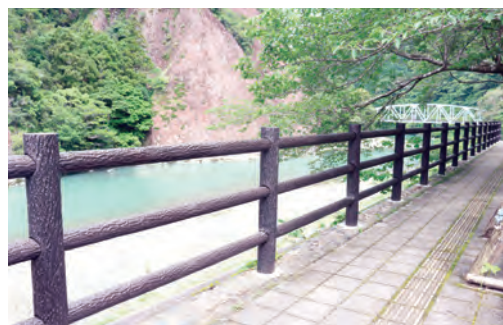
一枚岩観光物産センター転落防止柵取替工事
