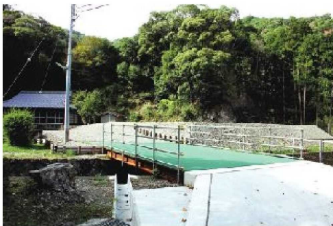
高瀬地区の高台（平成25年6月完成）
