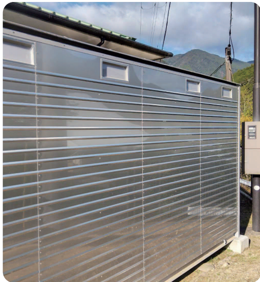
トイレトレーラー (高田地区)
