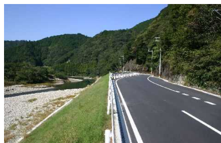
改良の進む国道371号
